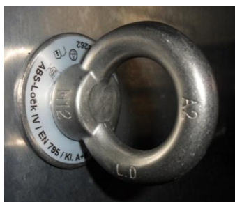
Afb. 11-11 Aanslagpunt voor de veiligheidsgordel
